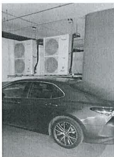
3-4-5-6. számú klímák (156. helyiség - ELMŰ trafó hűtése)
