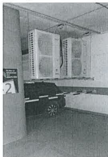
3-4-5-6. számú klímák (156. helyiség - ELMŰ trafó hűtése)
